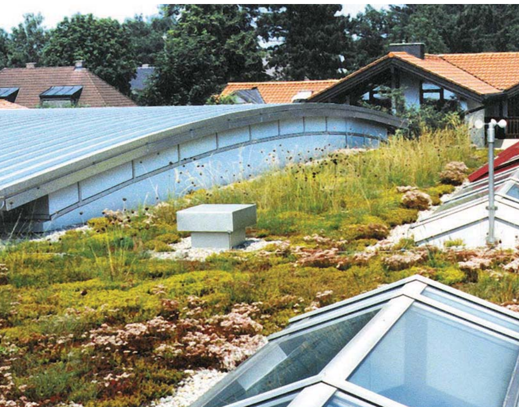
01-02| Příklady skladby jednoplášové vegetační střešních s parozábranou, tepelnou izolací a hydroizolací z asfaltových pásů
